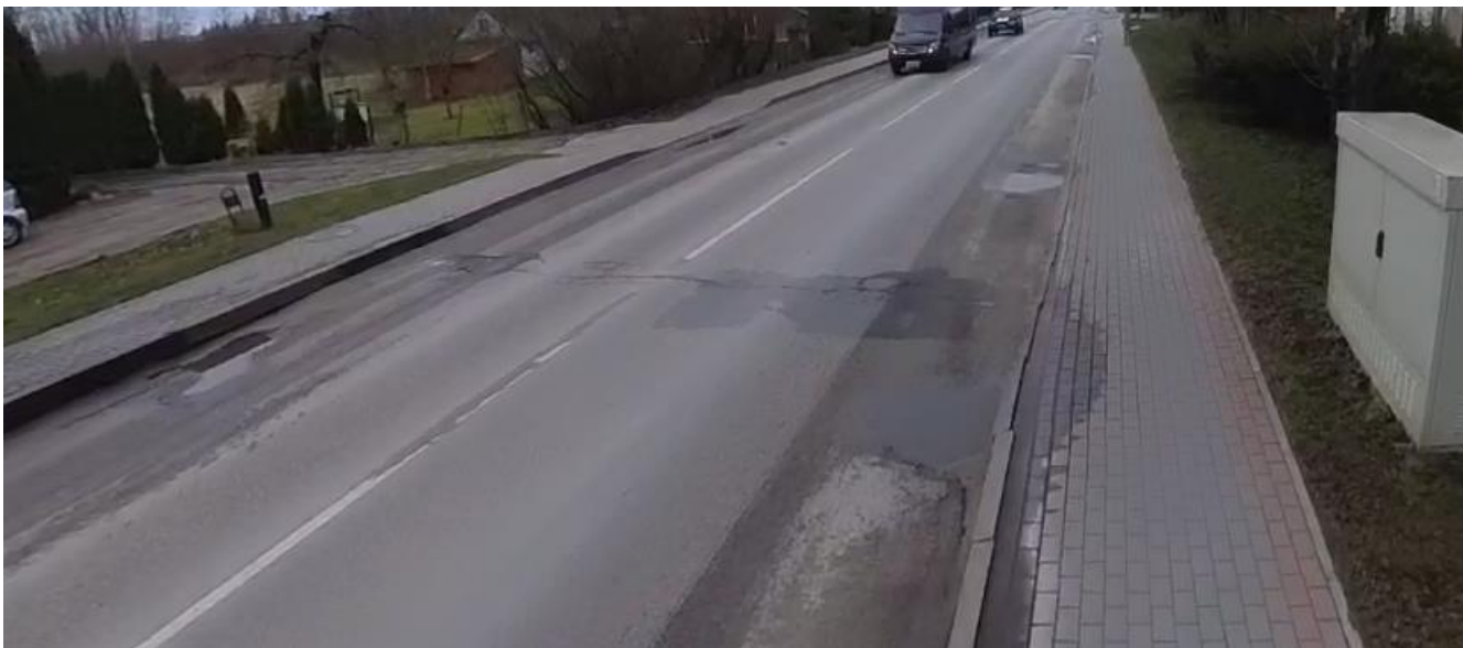
4 pav. Pažaidos asfalto dangoje
