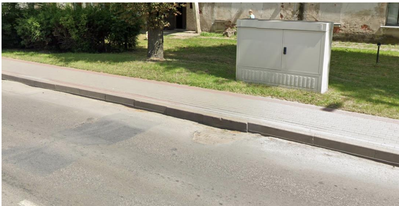
1 pav. Kelio bortų peraukštėjimas ir išsikreivinimas
