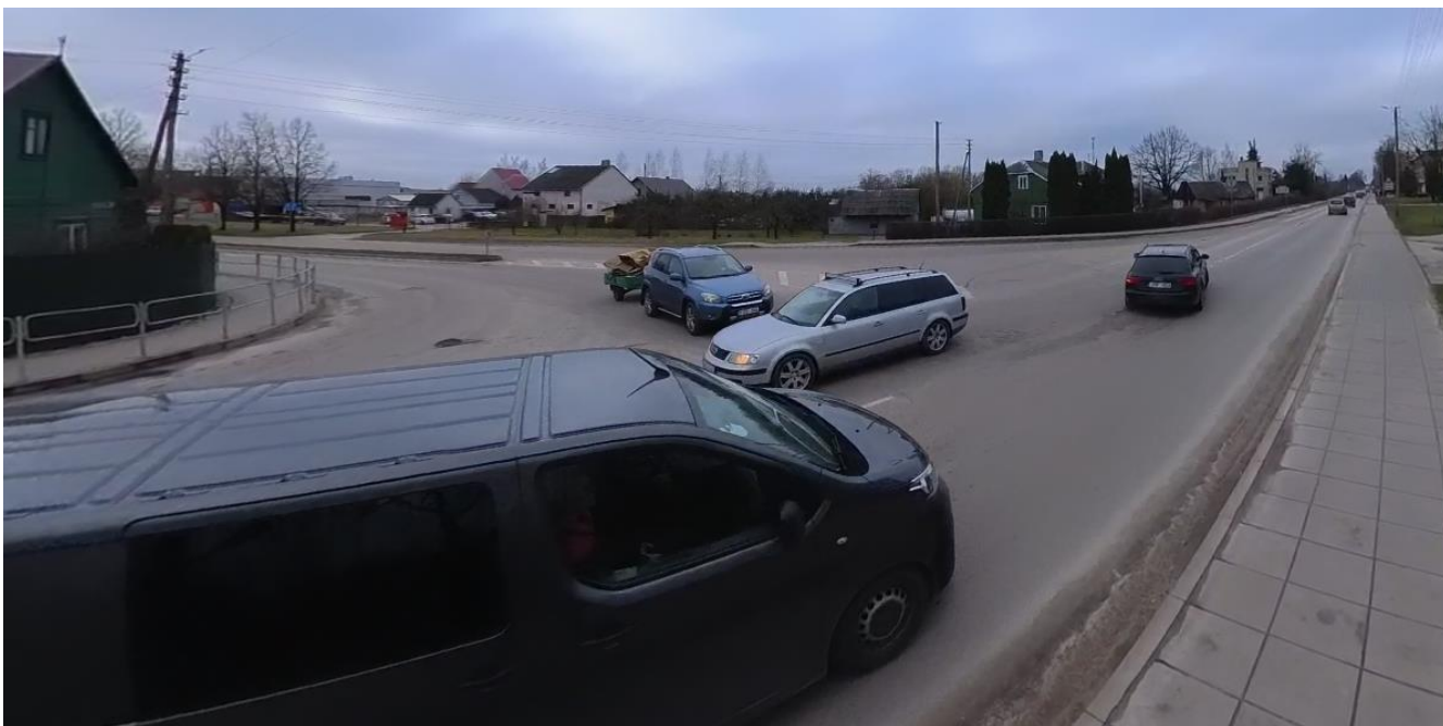
5 pav. Pėsčiųjų infrastruktūros trūkumas sankryžoje
