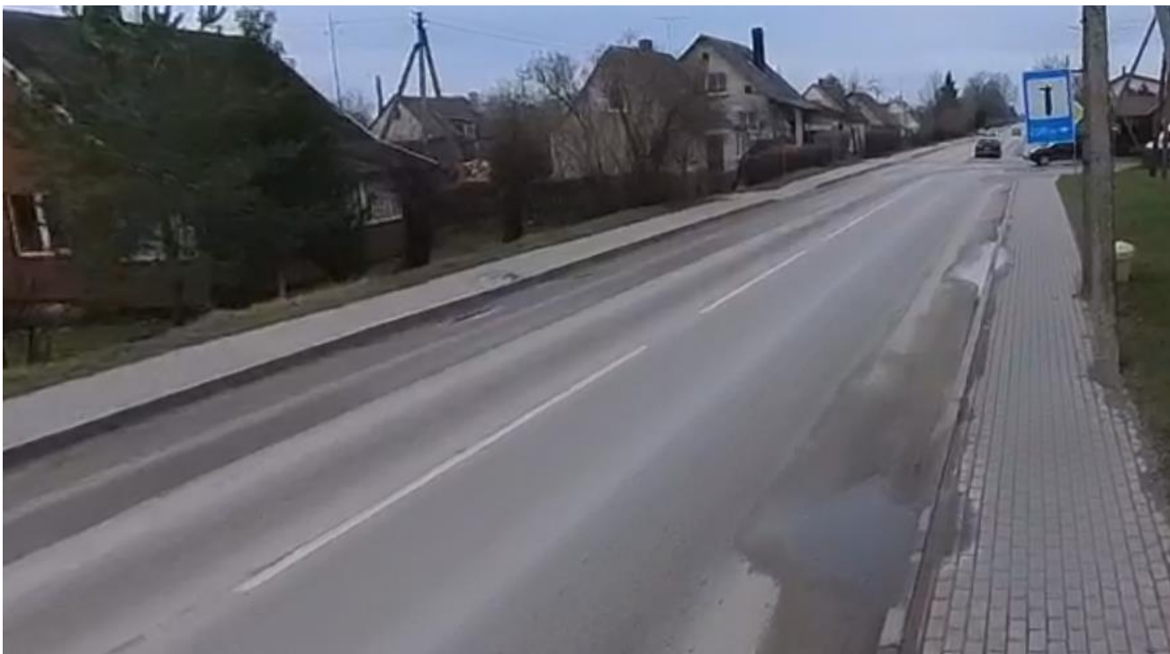
2 pav. Vandens kaupimasis važiuojamojoje dalyje po nedidelio lietaus
